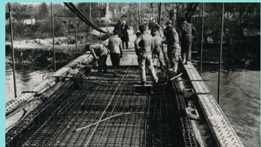
10 février 1949 : Travée centrale, coulage du béton de la dalle armée sous chaussée.
