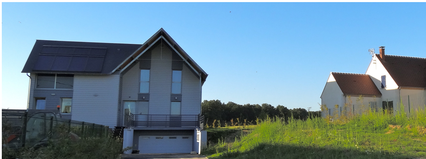
Maison contemporaine reprenant le volume et la forme d'une construction traditionnelle (Fleury)
