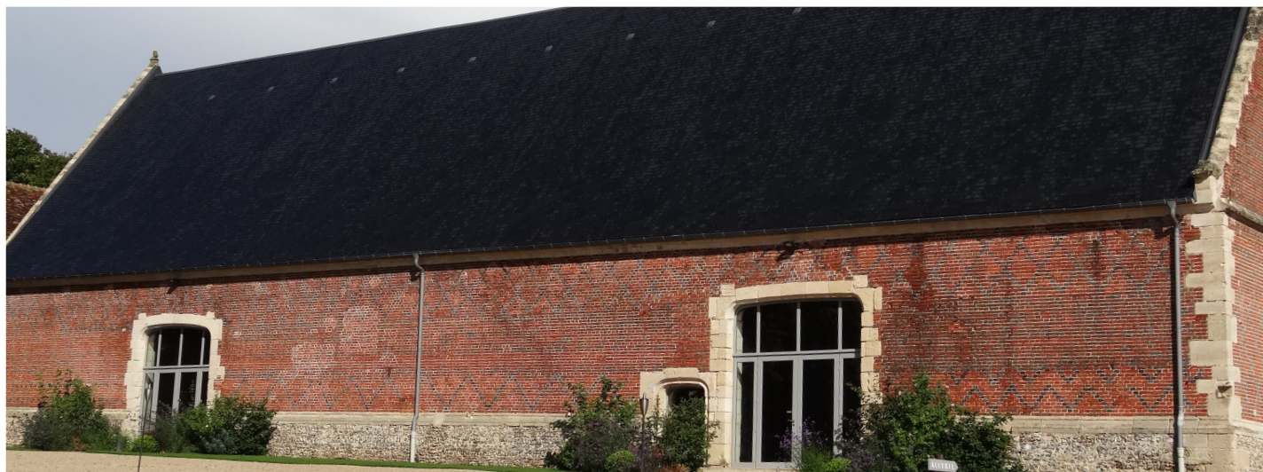
Grange convertie en locaux de séminaire (Boissy-le-Bois)
