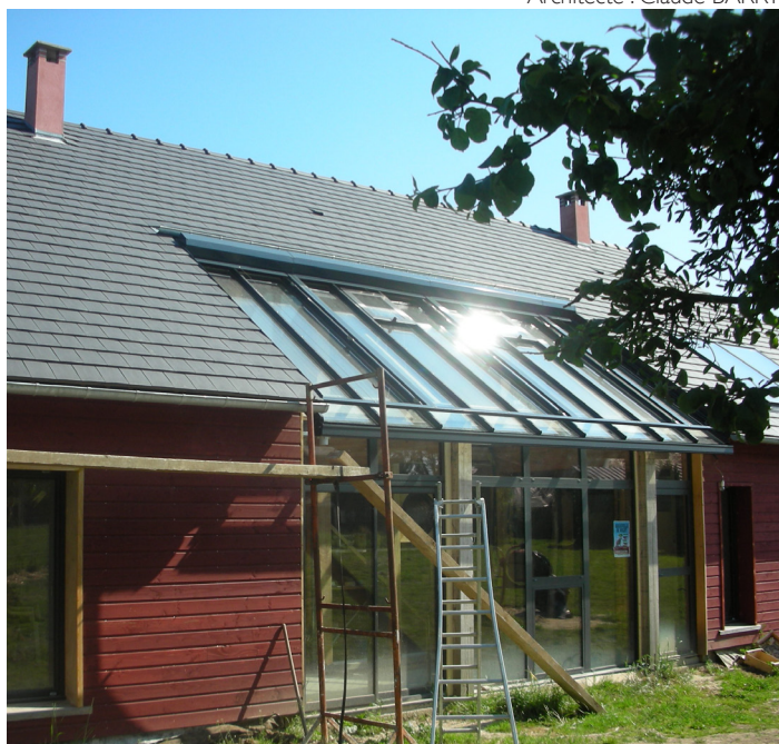
Création d'une verrière dans un volume traditionnel
