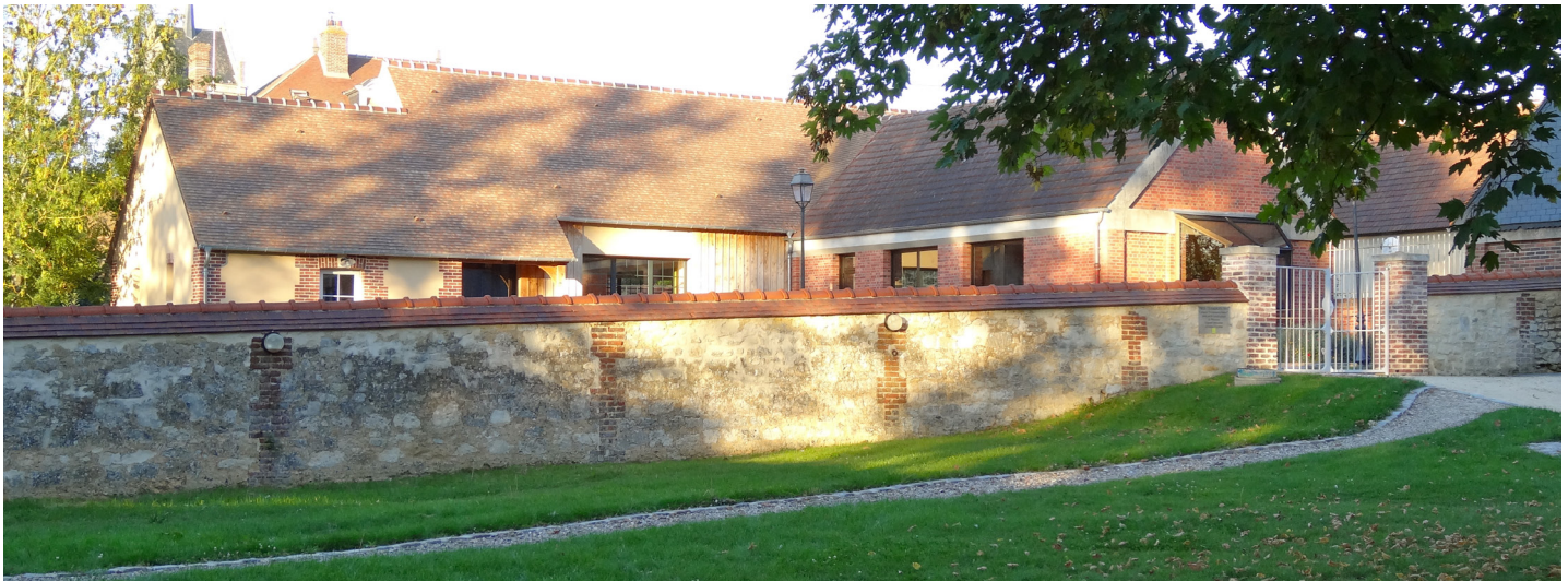
Mur composite (briques et moellons) clôturant un espace public
