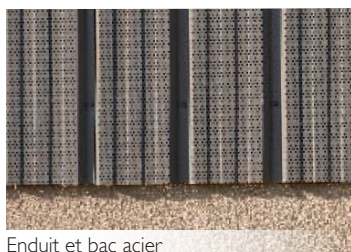
Enduit et bac acier
