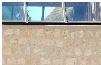
Moellons et vitrage
