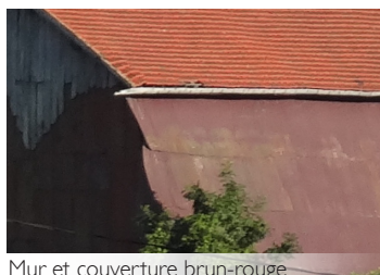
Mur et couverture brun-rouge
